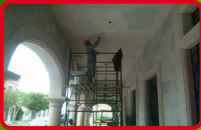
Pulido de bóveda, aplicación de pintura e instalación de molduras en Palacio Municipal.
