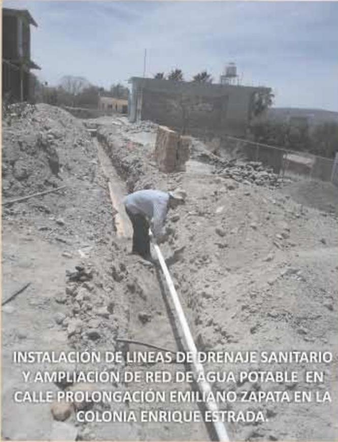
INSTALACIÓN DE LINEAS DE DRENAJE SANITARIO Y AMPLIACIÓN DE RED DE AGUA POTABLE EN CALLE PROLONGACIÓN EMILIANO ZAPATA EN LA COLONIA ENRIQUE ESTRADA.
