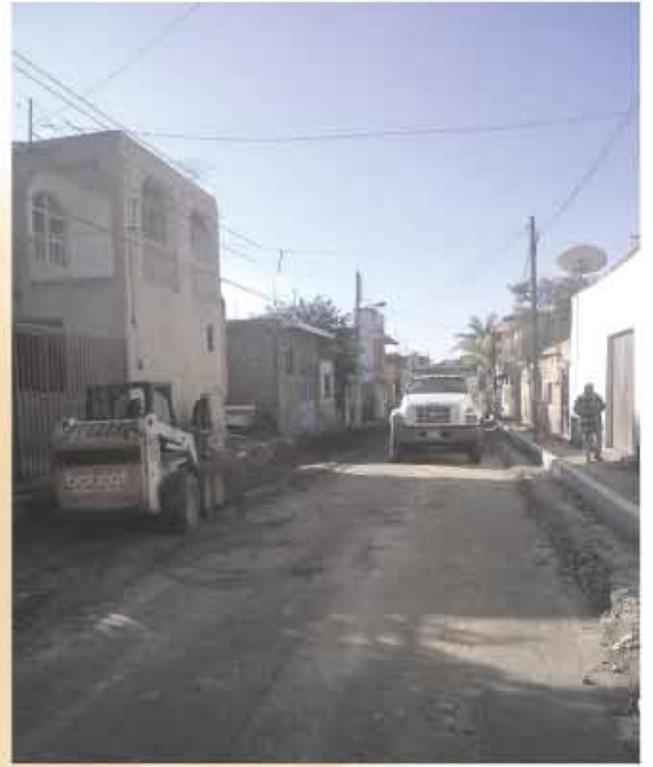
**BOBCAT** ESTE MÁQUINA FUE UTILIZADA DURANTE 683 HORAS, UNA DE LAS HERRAMIENTAS MÁS VERSÁTILES QUE TIENE EL PARQUE VEHICULAR, CON EL SE REALIZAN TRABAJOS TALES COMO: DESAZOLVE Y MANTENIMIENTO DE CAUCES DE ARROYOS. LIMPIEZA DE CALLES. APOYO DURANTE LOS TRABAJOS DE COLADO DE BACHES Y BANQUETAS POR PARTE DE LA CUADRILLA DE OBRAS PÚBLICAS.
